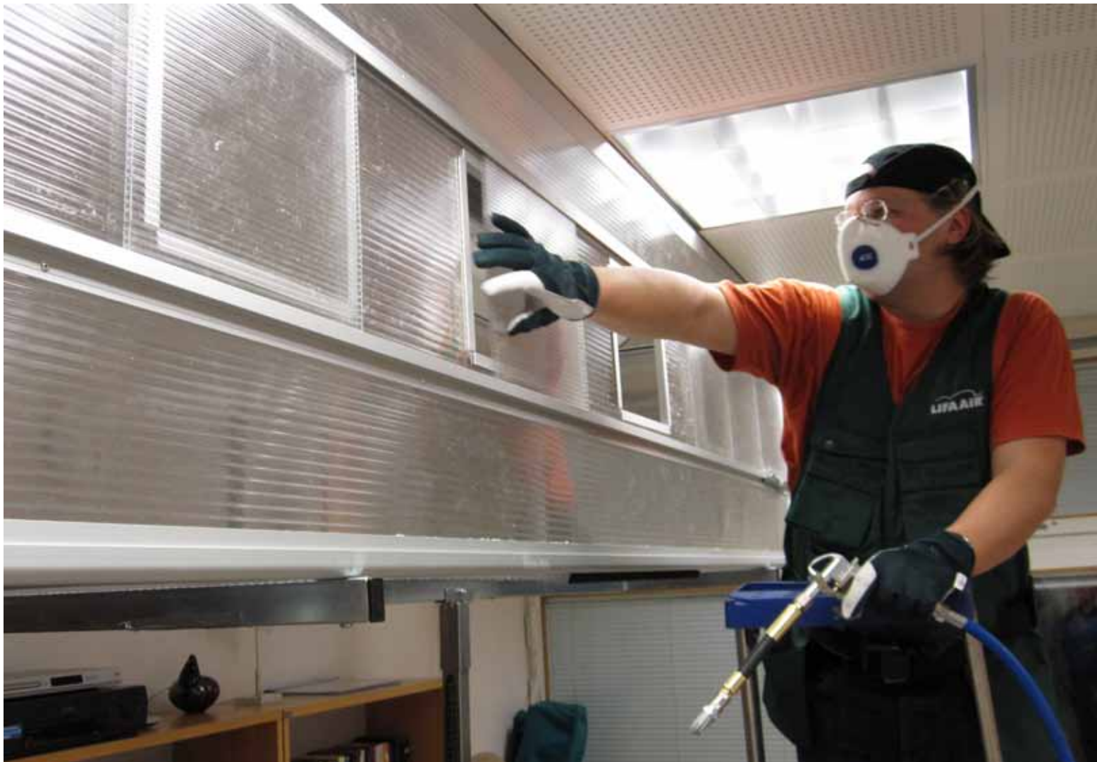
Ilmastointipalkki osastoidaan arkulla, puhdistetaan imuroimalla ja paineilmalla sekä tarvittaessa desinfioidaan.
